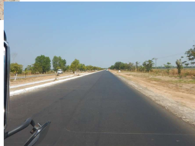
ピャポン・ヤンゴン間の幹線 アスファルトのムラがPM舗装であることを示唆している
