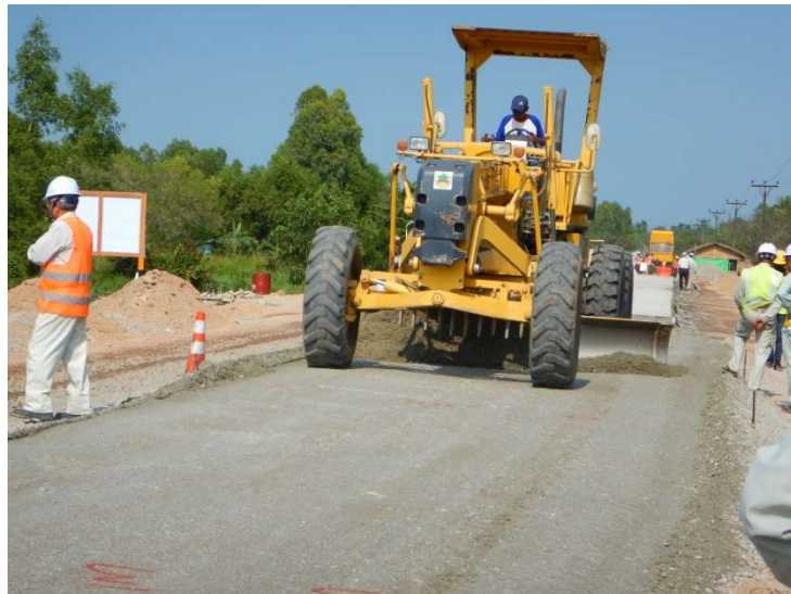
路盤の整正 オペレーターはMOC職員
