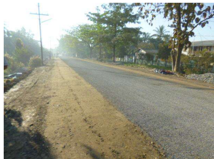
パイロット区間完成、その後MOCで拡幅 (このページの写真はJIP報告書による)
