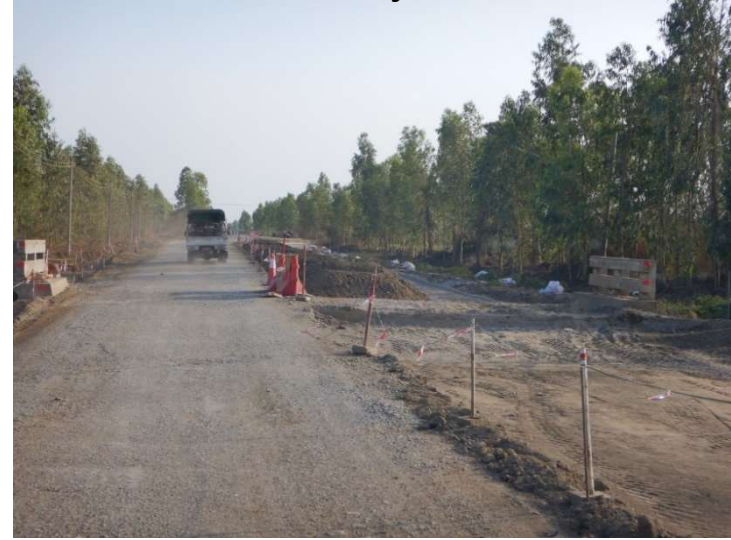
路床のセメントないし石灰安定処理施工中
