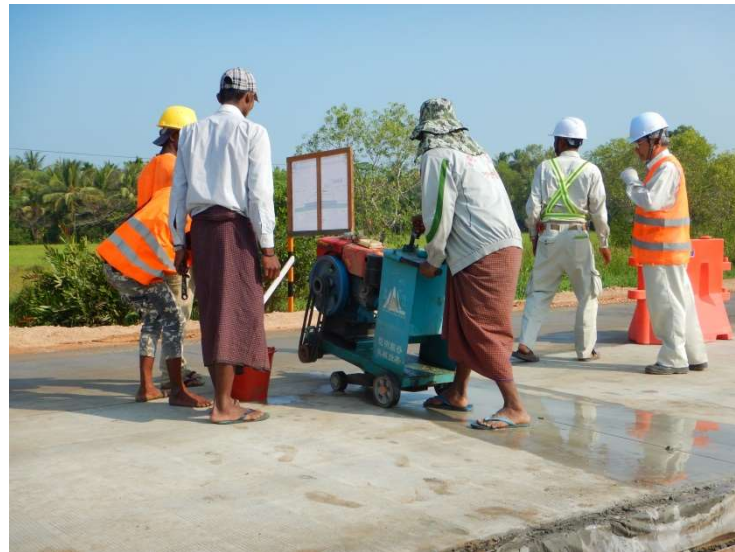
翌日打ち継ぎ目と5mピッチの収縮目地に カッターを入れる
