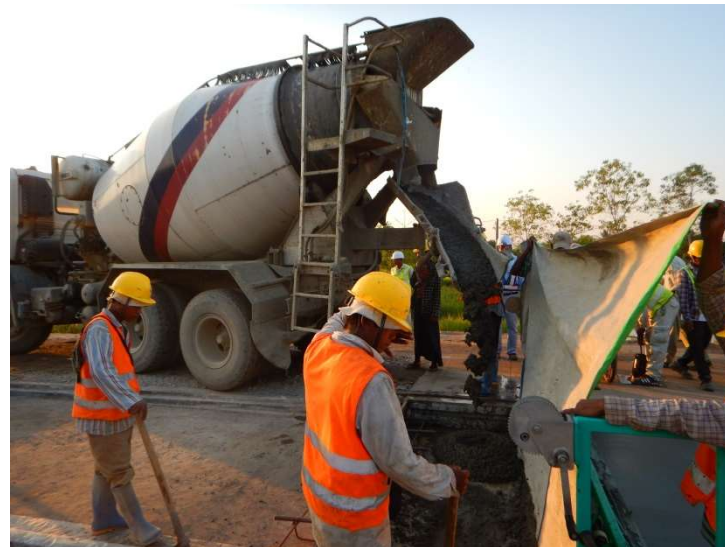
コンクリートミキサー車到着
