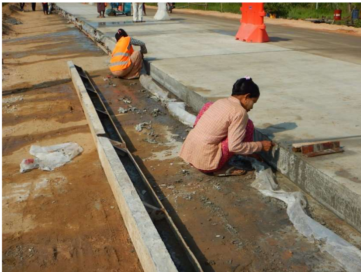
約1週間養生した後、型枠を外し、路肩工の準備
