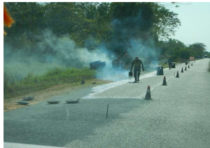
砂利の上に細粒の砂利を播き、如雨露で加熱アスファルトを散布
