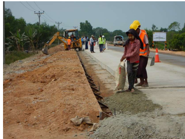
路肩に良質材料(碎石)を投入(1.2m幅) 、セメント袋は運搬用容器として使う
