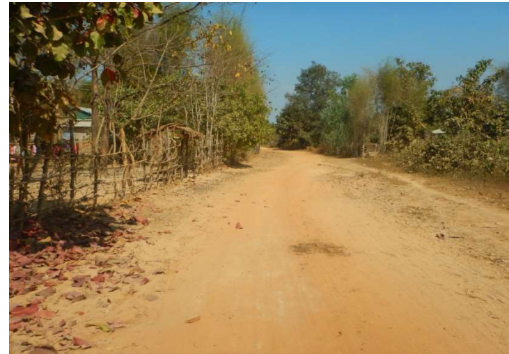
地図にあるレベルの道路もこの状態（Yoma橋へ）
