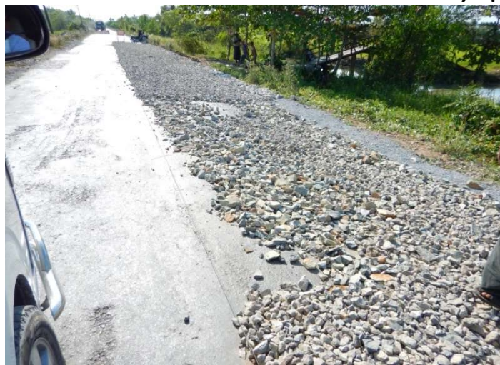
乾季に路面の補修を行う、浸透マカダムの砂利層の舗設
