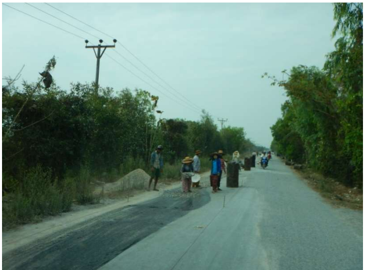
アスファルトを散布状況、雇用対策も?
