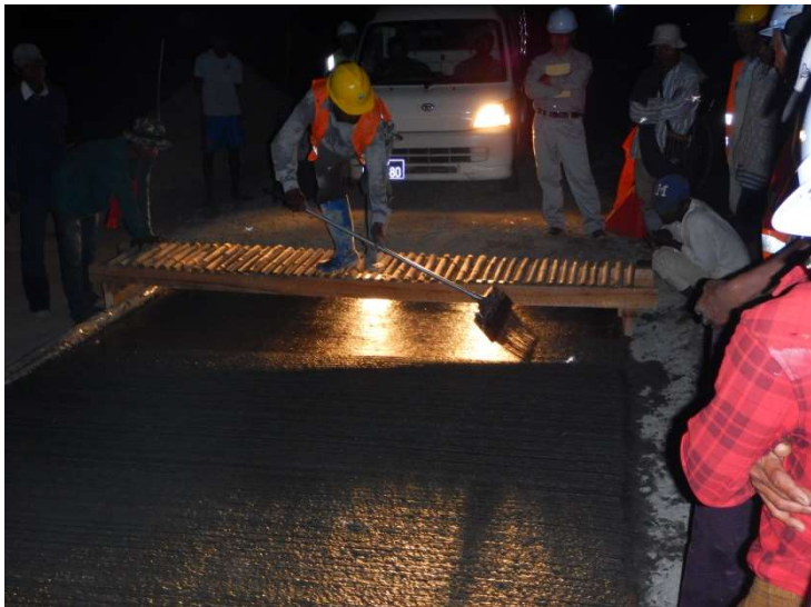
手製箒による箒目付け、仕事が長引き夜間工事に
