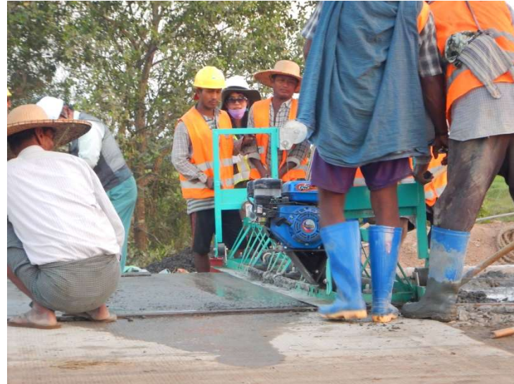
簡易フィニッシャーによる仕上げ
