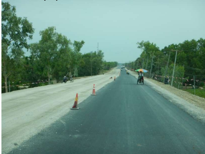
基層が舗設された区間
