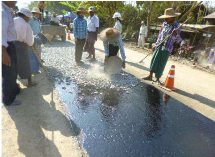
第1層施工中 多層表面処理舗装
