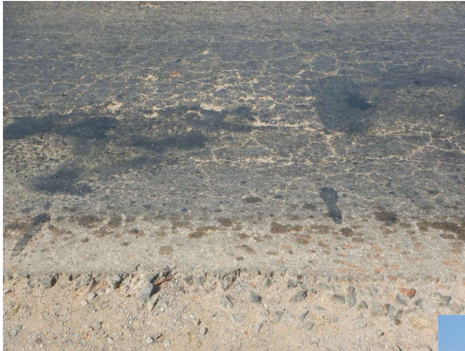
ピャポン・ヤンゴン間の幹線 アスファルトのムラがPM舗装であることを示唆している
