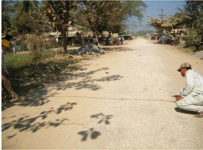
施工前 丁張準備
