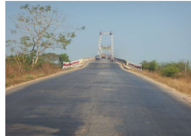
ピャポン・ヤンゴン間の幹線 アスファルトのムラがPM舗装であることを示唆している
