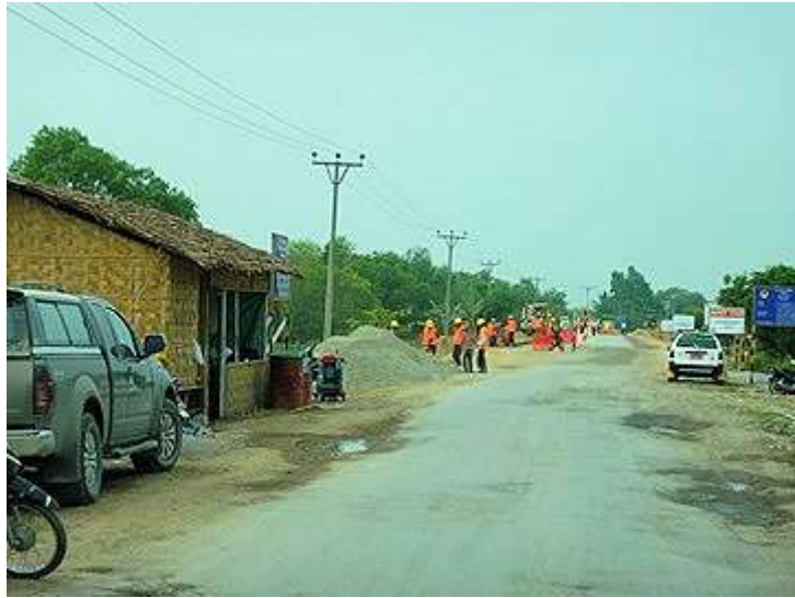
パイロット工区、左の建物が現場事務所
