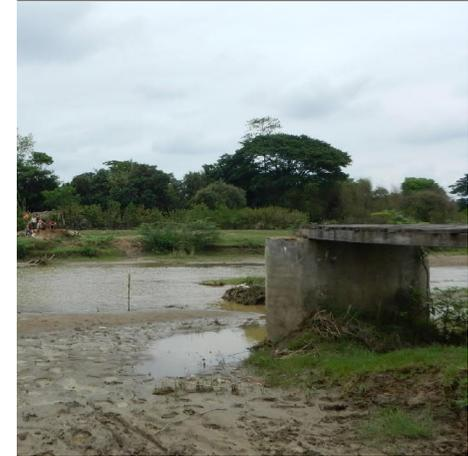
橋梁技術の専門家として派遣されてから40年あまりミャンマーの技術者と交流してきた国際インフラパートナーズの朝倉肇副理事長がミャンマーに出張していたとき、住民が作った橋が洪水で流されて復旧したばかりなのに再び流されて学童も登校ができずに困っているという新聞記事が目にとまりました。ただちに現場を視察しましたが、新聞の写真や現地の写真からわかるように、村人が自分たちで作った橋は、かわどこに橋脚を置き、橋げたを載せただけのもので、少し大きい洪水が起きたらひとたまりもないものでした。朝倉さんはちゃんとした沈下橋で架けなおすのがよいと提案し、外務省に日本NGO連携無償資金協力として採択されたのが始まりです。これは2015年のことでした。
