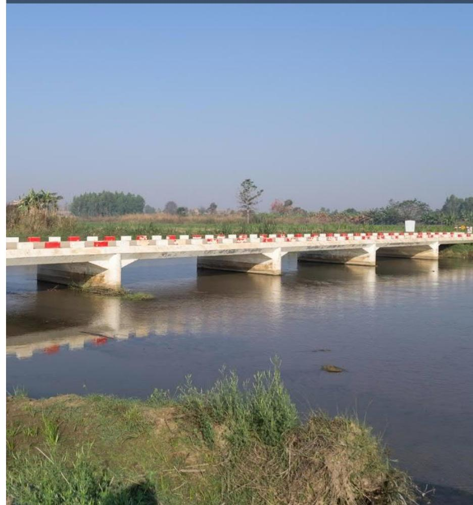
沈下橋は日本にも多くあります。日本は豊かになったので今から沈下橋を新しく作ることはなく、既存の沈下橋もぼっすいきょうに架け替えるようにしていますが、観光地にもなって有名なしまとがわだけでなく首都圏の荒川などにもあって、近隣の人々によって使われています。右の写真は国際インフラパートナーズがミャンマーに作った沈下橋の例ですが、洪水時に流れの邪魔になって上流の水位が上がることを防ぐよう、欄干の代わりに紅白のコンクリートブロックで仕切っています。紅白のコンクリートブロックはミャンマーでガードレールの代わりによく用いられているので人々にも違和感なく受け入れられています。
