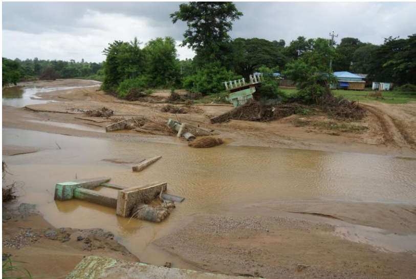
某国NPOが架けた橋 基礎が形だけ
