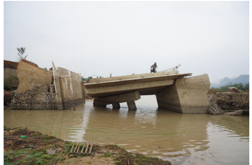
農村開発局が架けた橋 橋台も橋脚も洗掘して崩壊
