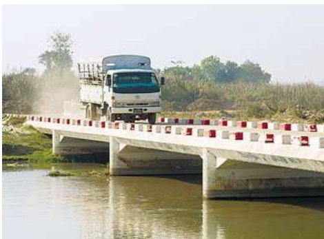
完成した沈下橋
