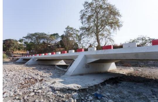
橋桁周囲にコンクリートが流されていた
