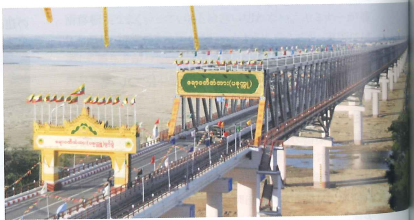
写真-5 パコック橋。全長約3,500mはミャンマー最長を誇る
