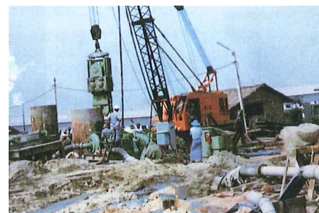
写真-3 ツワナ橋建設でのリバースサーキュレーションドリルによる場所打ち杭の施工
