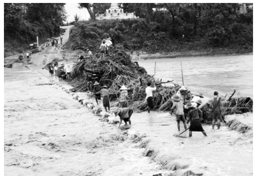
写真-8 テザ橋に堆積した流木の山を処理する村人たち
