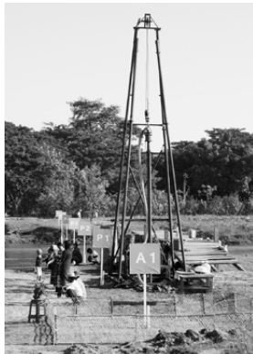
写真-5 地方部でも施工できる現場打ち杭を採用
