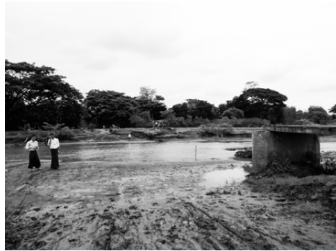
写真-3 落橋後の様子(歩いて渡るほかなく、雨が降れば学校にも行けなくなる)
