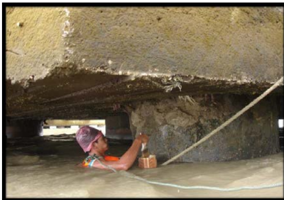
写真-3.13 杭頭部の補修
