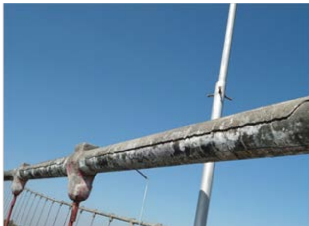
写真-4.38 主ケーブルの被覆
