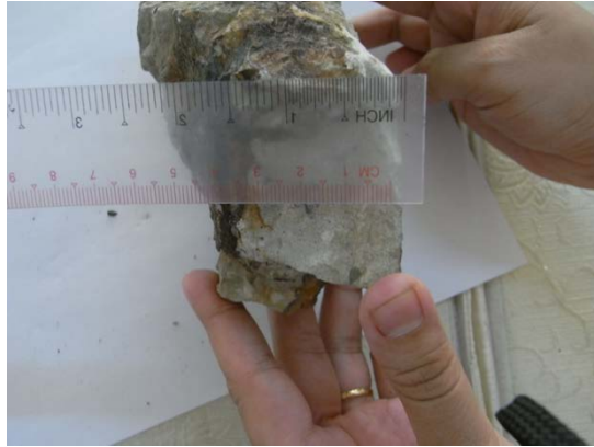
写真-4.62 鉄筋の腐食とコンクリートかぶり
