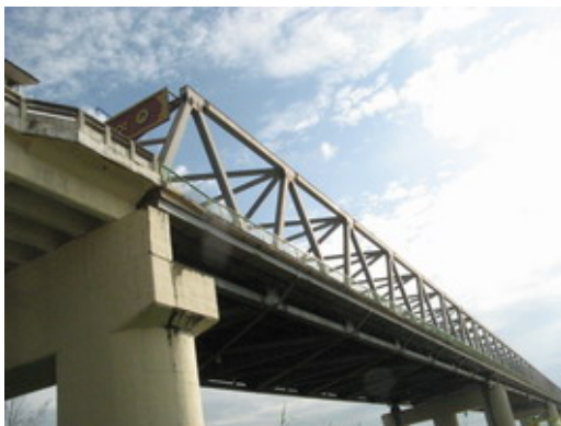
写真-4.54 Shwe Pyithar 橋
