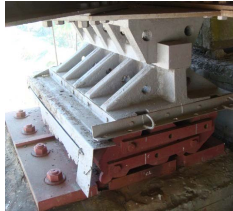
写真-4.27 支承 (Maubin 側)
