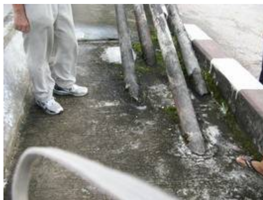
写真-4.22 ケーブルの路面貫通部
