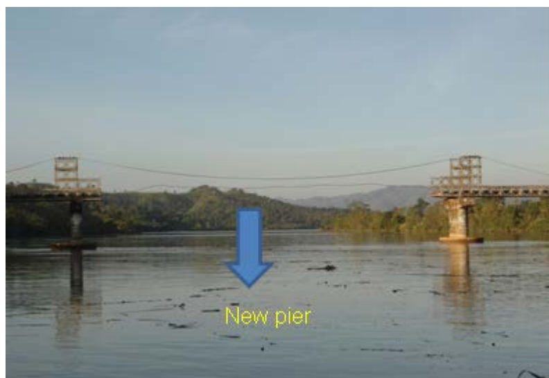
写真－4.40 復旧中の Da let-Chaung 橋
