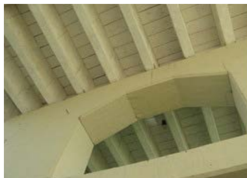
写真-4.58 アプローチのコンクリート橋の床板
