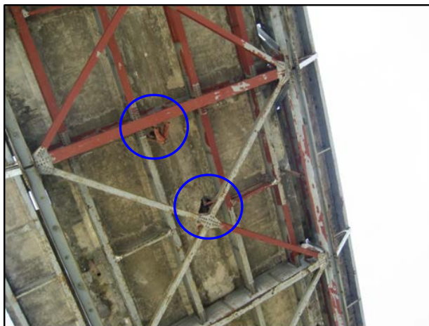
写真-4.64 塗り替え作業（円内は命綱だけで作業する職人）
