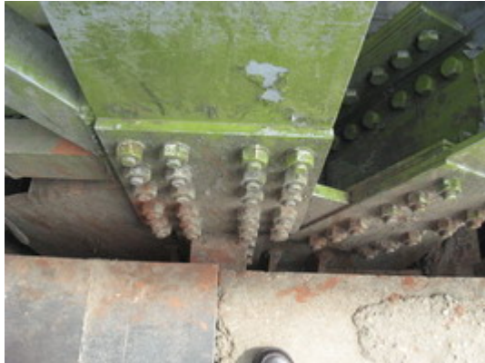
写真-4.15 トラスの格点部
