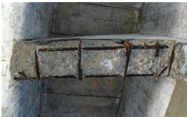
写真-4.67 アプローチのコンクリート橋の横梁
