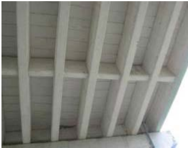
写真-5.1 コンクリート桁橋の床板（Type I）
