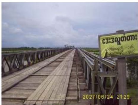
写真-3.7 ベアリー桁による橋梁
