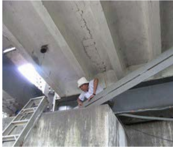
写真-5.2 Bayinaung 橋の床板 (Type II)
