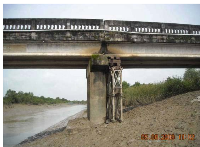
写真－4.5 設置された仮支持
