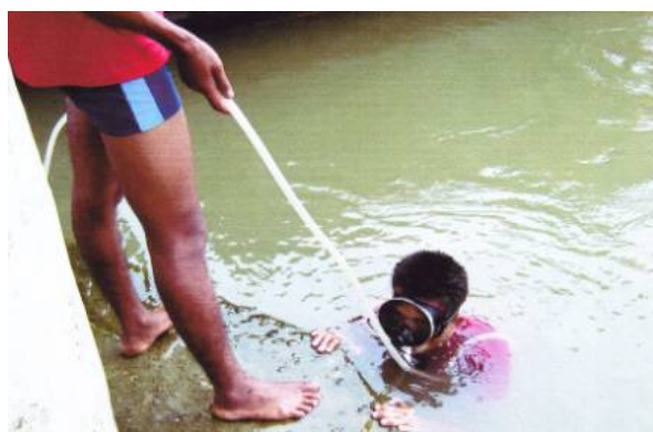
写真-3.16 杭の水中部の調査
