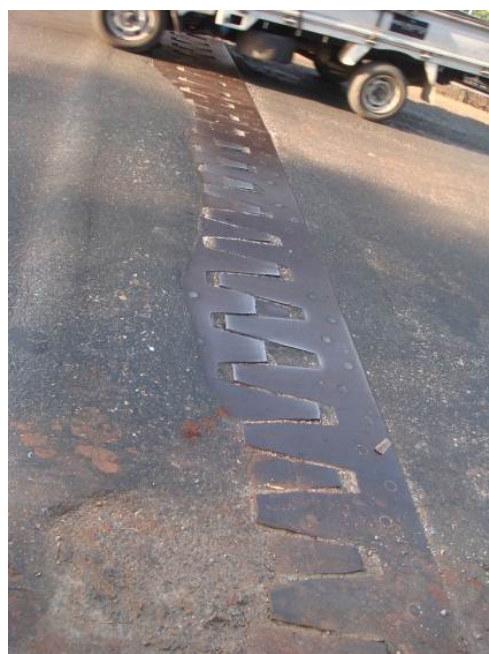
写真-4.12 伸縮装置 （ヤンゴン対岸側）
