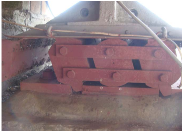
写真-4.26 支承 (Yangon 側)
