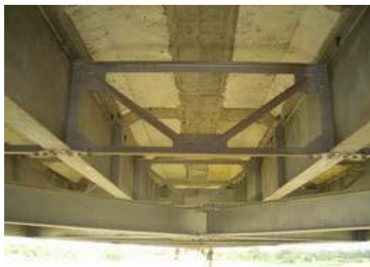
写真-4.30 プレキャストコンクリート床板
