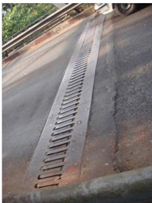
写真-4.11 伸縮装置 （ヤンゴン側）
