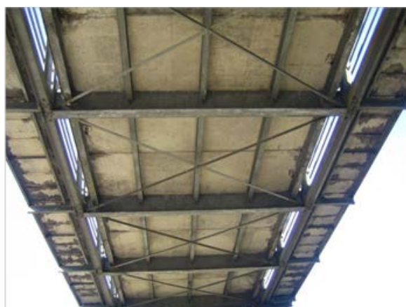
写真-4.2 Kyaunkong 橋の床板
