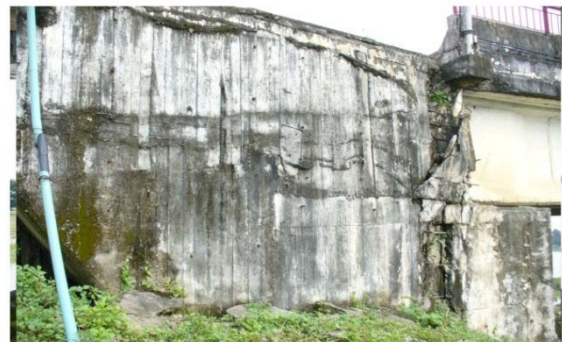
写真-4.29 橋台 (Maubin 側)
