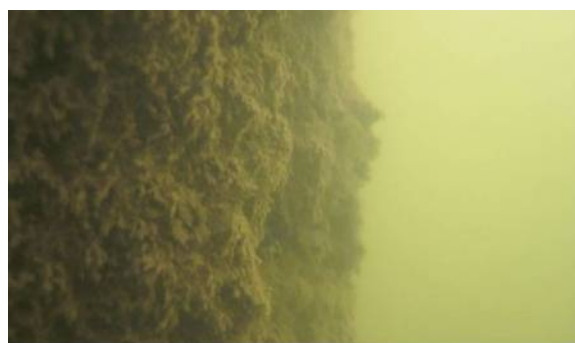
写真-3.17 杭の水中部の写真
