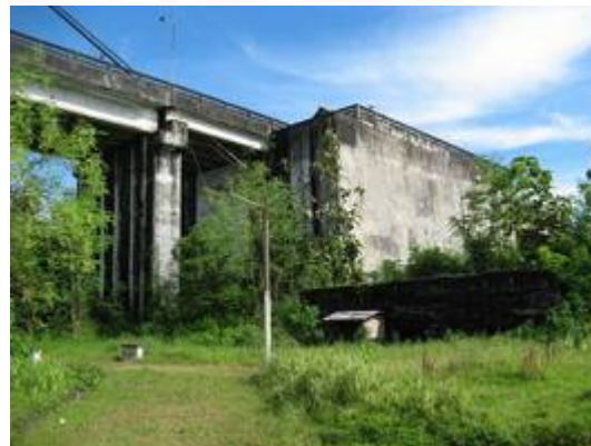
写真-4.18 南側アンカーレッジ
