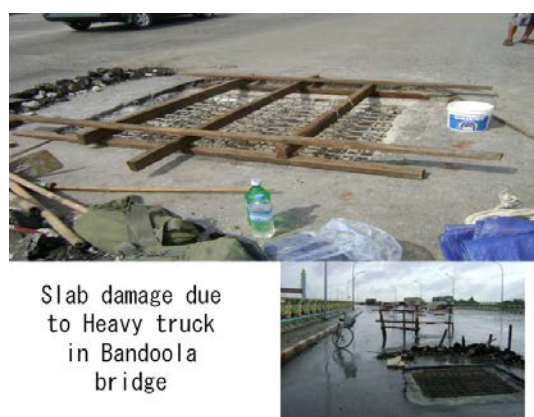
写真-4.53 床板補修中
