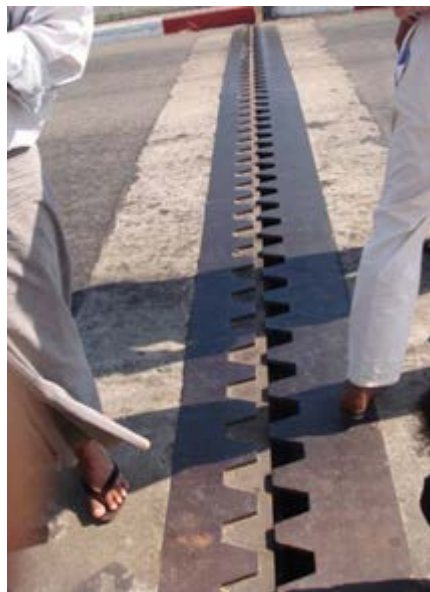
写真-4.80 伸縮装置 H5 の現況
