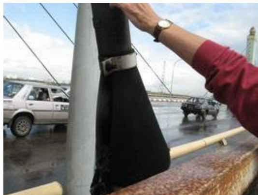
写真-4.51 ケーブル定着部
