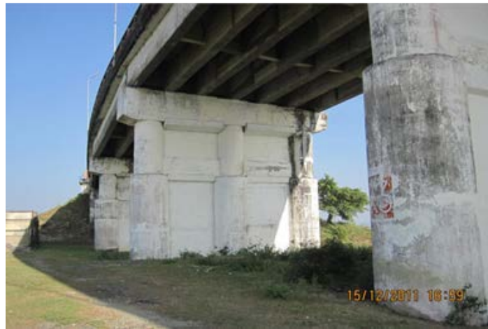
写真-4.63 Min Chaung 橋の橋脚のコンクリート巻き立て補強
