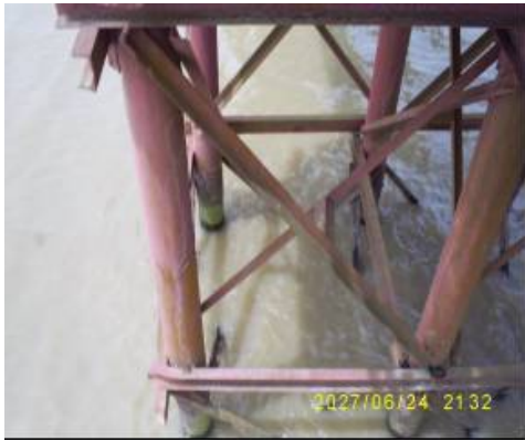
写真-3.9 パイプ橋脚
