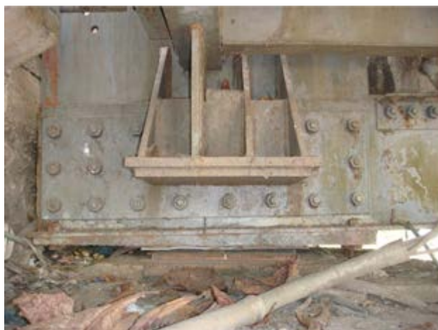
写真-4.10 可動沓（ヤンゴン対岸側）
