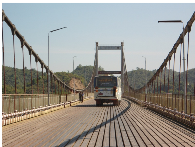
写真－4.37 橋面型鋼の変形
