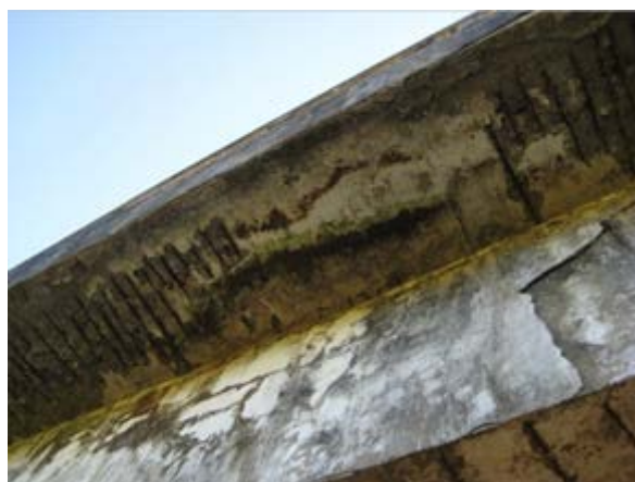
写真-4.66 アプローチのコンクリート橋の歩道部下面
