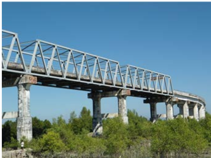
写真-4.75 Min Kyaung Chaung 橋
