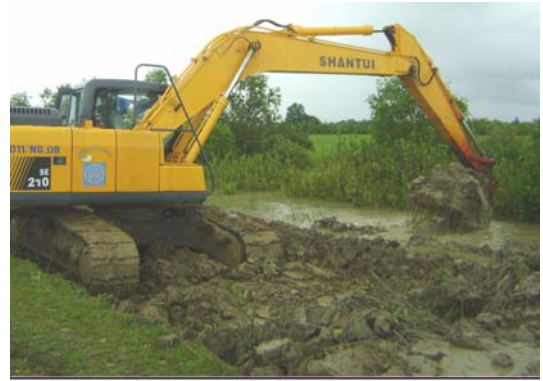
写真-29 Mawlamyinegyun 付近で No.1 Road から分岐する No.2 Road の起点。盛土は完成しているが路面処理が出来ていないので、車両はまだ通行できない。この地域では、道路建設ルートの内脇の田んぼを浚渫し、その泥を盛り上げて盛土を築いているが、田んぼの表面の堆積泥を浚渫しているので、盛土材としては強度不足であり、盛土が崩れかけている。右の写真は他の道路であるが、盛土をしているときの様子(PW 提供)。
