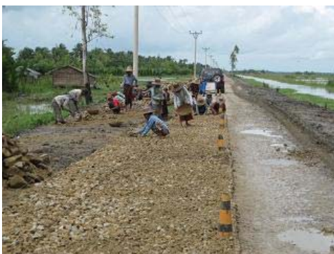
写真-32 拡幅した盛土の上にマカダム舗装を施工している。
