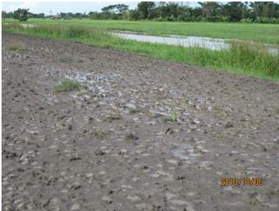
写真-29 Mawlamyinegyun 付近で No.1 Road から分岐する No.2 Road の起点。盛土は完成しているが路面処理が出来ていないので、車両はまだ通行できない。この地域では、道路建設ルートの内脇の田んぼを浚渫し、その泥を盛り上げて盛土を築いているが、田んぼの表面の堆積泥を浚渫しているので、盛土材としては強度不足であり、盛土が崩れかけている。右の写真は他の道路であるが、盛土をしているときの様子(PW 提供)。
