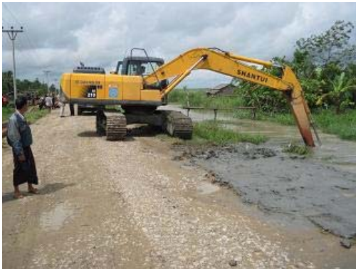
写真-34 盛土の拡幅をしているところ。既存の盛土の土とは明らかに違う。ほとんどヘドロ。
