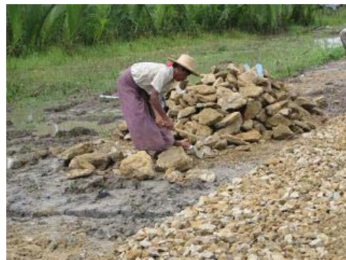
写真-33 碎石は人力で行っていたが、粒度調整はされていない。
