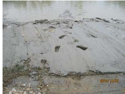
写真-35 子供の足跡もずっぽりと沈んでしまうほど軟弱なヘドロ。川底の表面のヘドロを除去し、深いところから少しでも良質な土を浚渫するべき。
