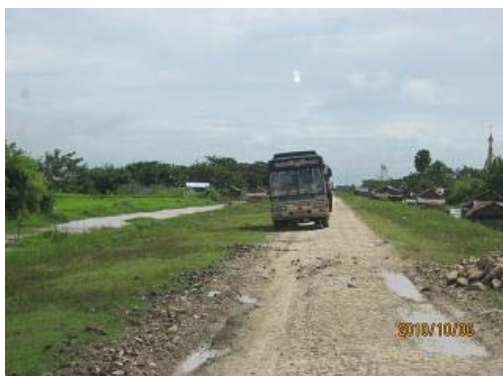
写真-20 大型車両も通行している。
