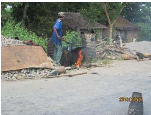
写真-13 アスファルトを焚き火で加熱して浸透させている。
