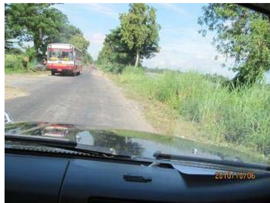
写真-14 大型交通の道路でも、瀝青浸透式の簡易舗装で、路肩は舗装せず、側溝も無いという、典型的な途上国の道路構造。
