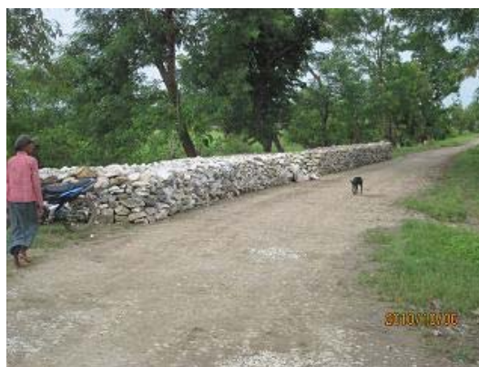
写真-26 マカダム用の石材。80km 離れた採石場から運搬している。
