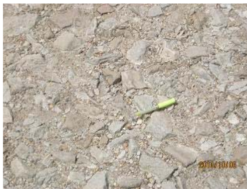
写真-19 がたがた道で時速 20km/h くらいでしか走れない。瀝青剤を使った表面処理が必要と思われる。
