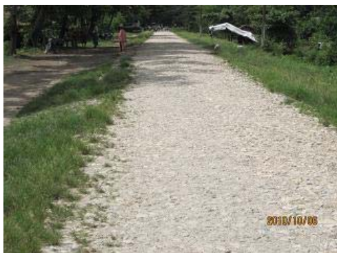
写真-18 No. 1 Road の Maubin 近郊。いわゆるマカダム舗装が施工されている。
