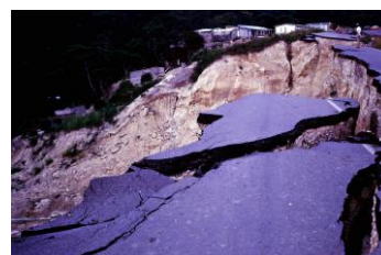
写真4.4 アンデス山脈中の地震による液化流動の現場(1981年2月撮影)
