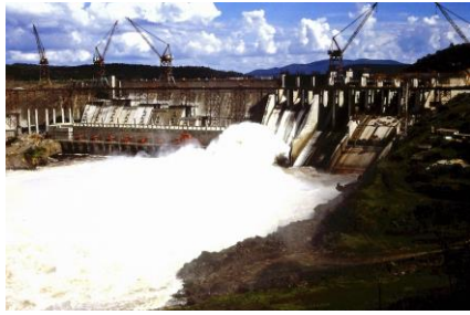
写真4. 7 グリダム余水吐 きから 3000m 3 /s 放流中
