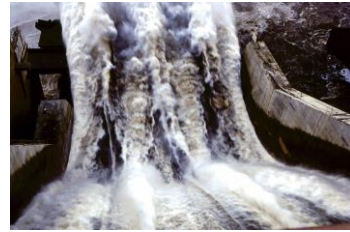
写真4. 8 グリダム余水吐 きから 3000m 3 /s 放流中、上流 から下流方向に撮影
