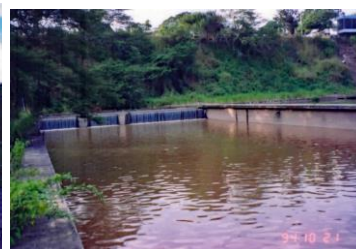
写真1.9 貯水池の上に枝が伸び、除塵機を運転していない証
