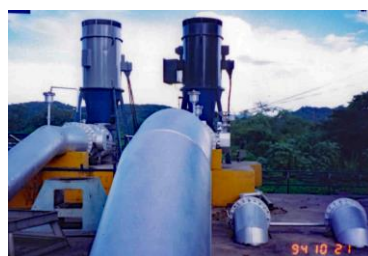
写真1.8 ツイ川から貯水池への取水ポンプ
