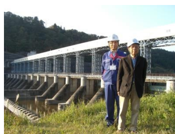
写真5.3 よう壁が倒れていたところに建設された揚川ダムで2015年10月21日に撮影
