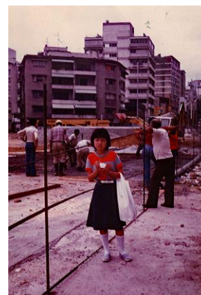
写真 1. 13 カラカス地下鉄の工事現場、写真中央は筆者の長女
