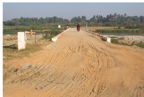
サミヤ村から見たメッタ橋と 通行止めゲート
