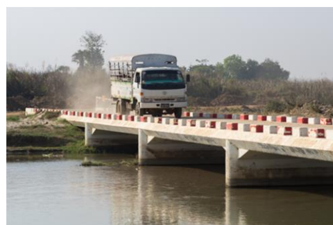
車両もよく沈下橋を渡る
