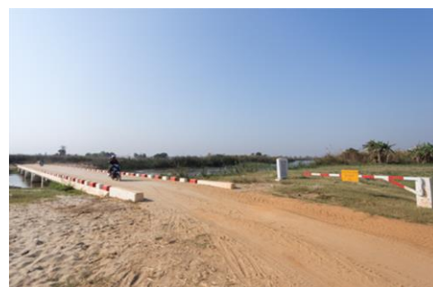
アウンラン町側オウシッコン村から見たメッタ橋と通行止めゲート
