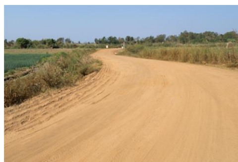
沈下橋完成後、整備された土の道
