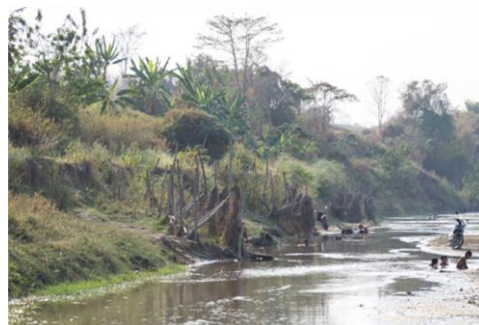
村の自助努力で建てた河道を変えないための柱
