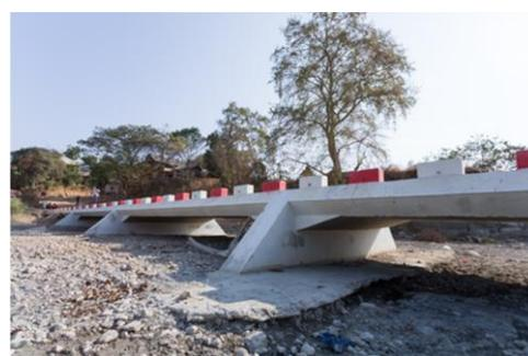
橋桁周囲にコンクリートが流されていた
