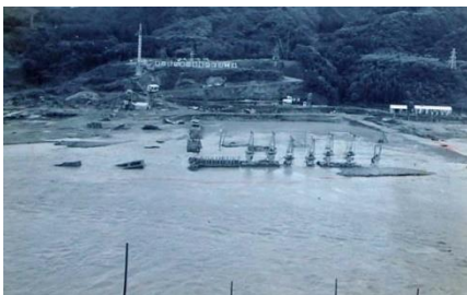
写真5.2 1951年8月4日の揚川発電所建設現場でよう壁が倒れている(東北電力撮影)
