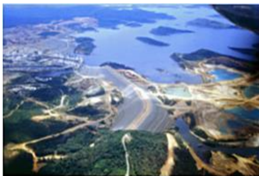
写真6. 3 当時建設中のグリダム1
