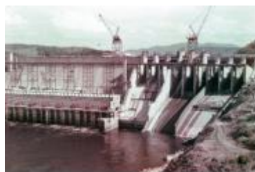
写真6. 4 当時建設中のグリダム2
