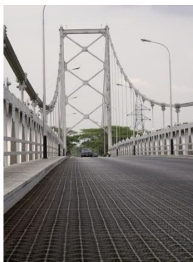
写真6. 10 最近建て替え完成直前のブルーサークル橋梁（グーグルアース）
