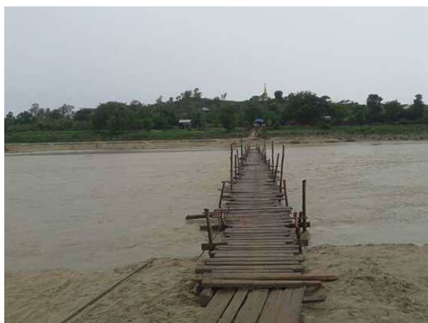
写真 補 8 Seikpyu の仮橋
