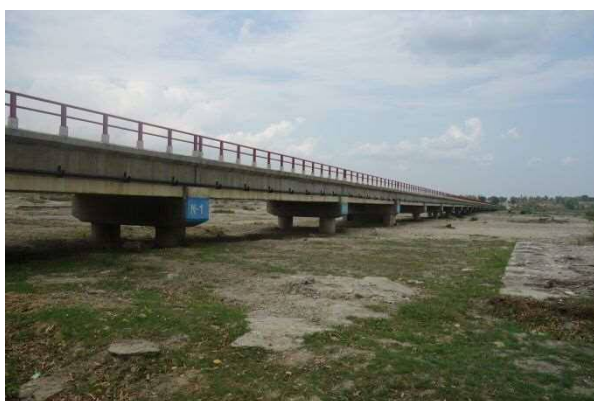
写真 補 16 2015 年に完成した Ohntaw 橋
