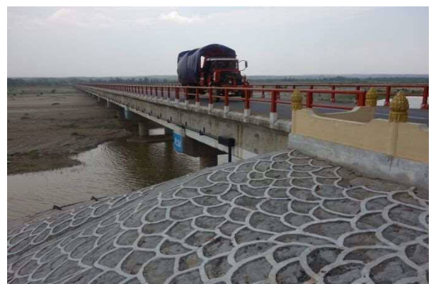
写真 補 17 2015 年に完成した Yapyar 橋
