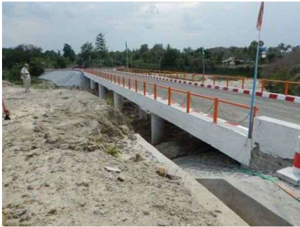
写真 補 3 ミャンマー建設省が設計・施工した「沈下橋」
