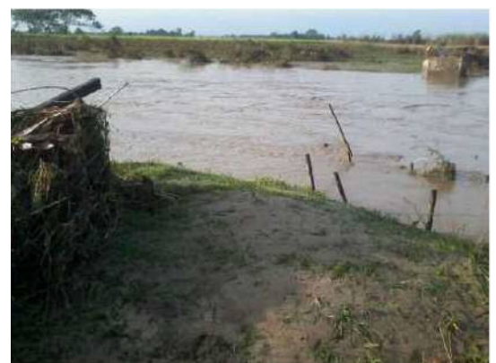
写真 3.4 流失後の状況
