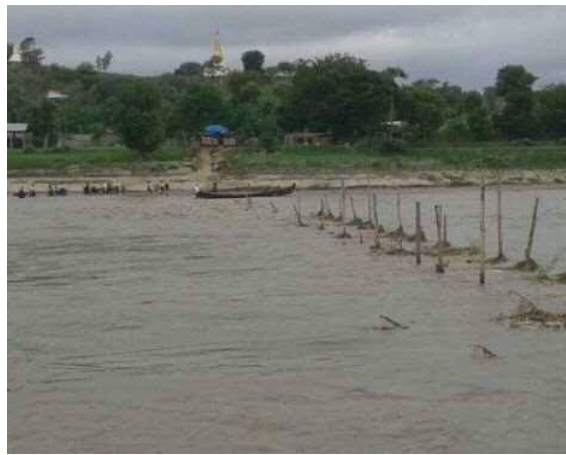
写真 補 9 雨季に入り流される仮橋
