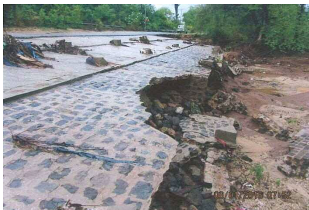
写真 補 6 破壊しつつある Causeway
