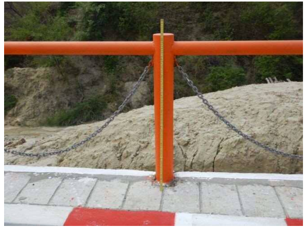
写真 補 4 高欄の状況
